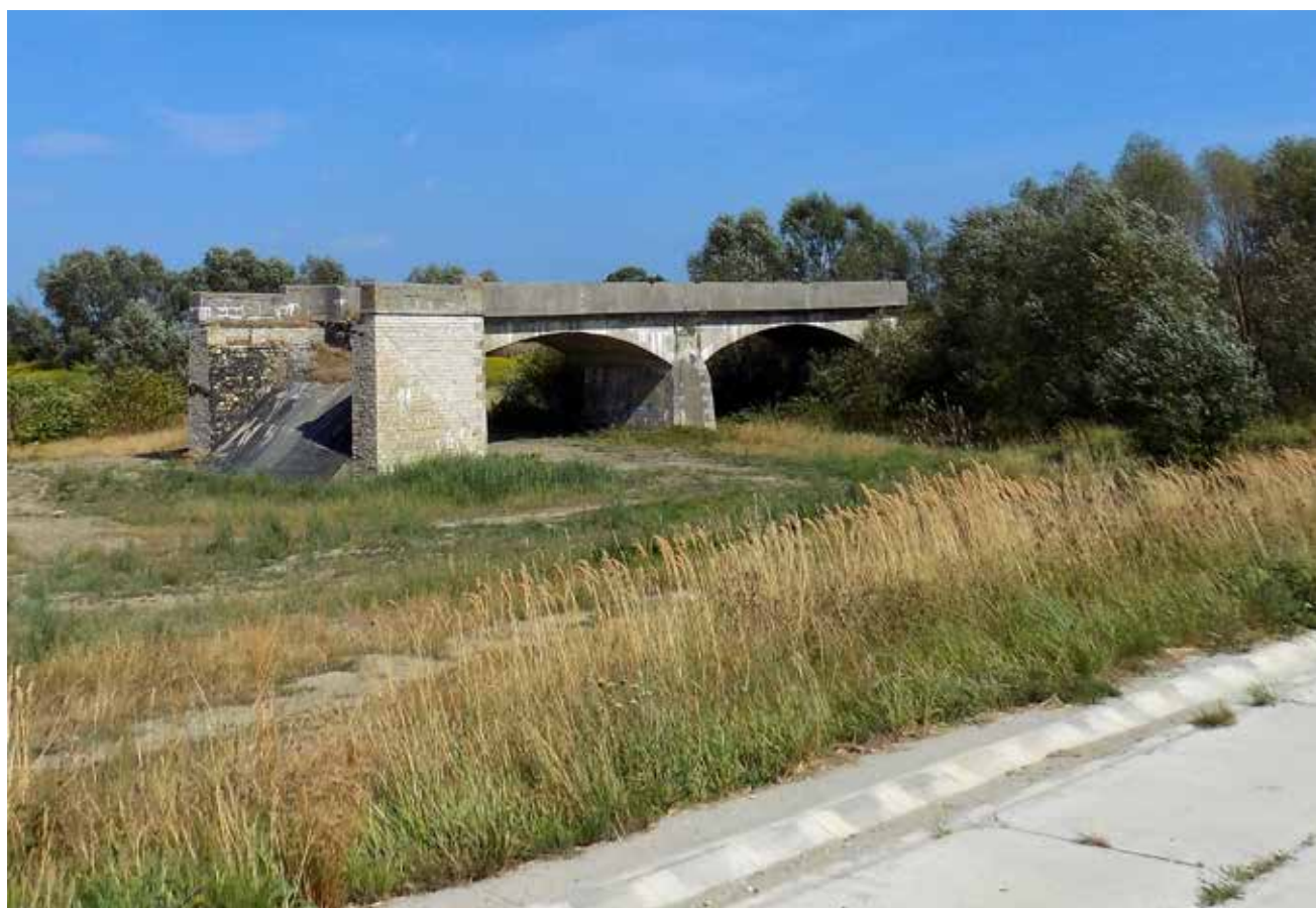
Przyczółek mostowy od strony Grzegorzowic
